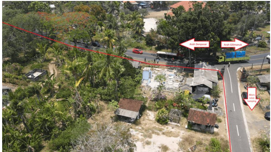
Dokumentasi: Survei Lokasi Lahan Pembangunan RSA Bali
